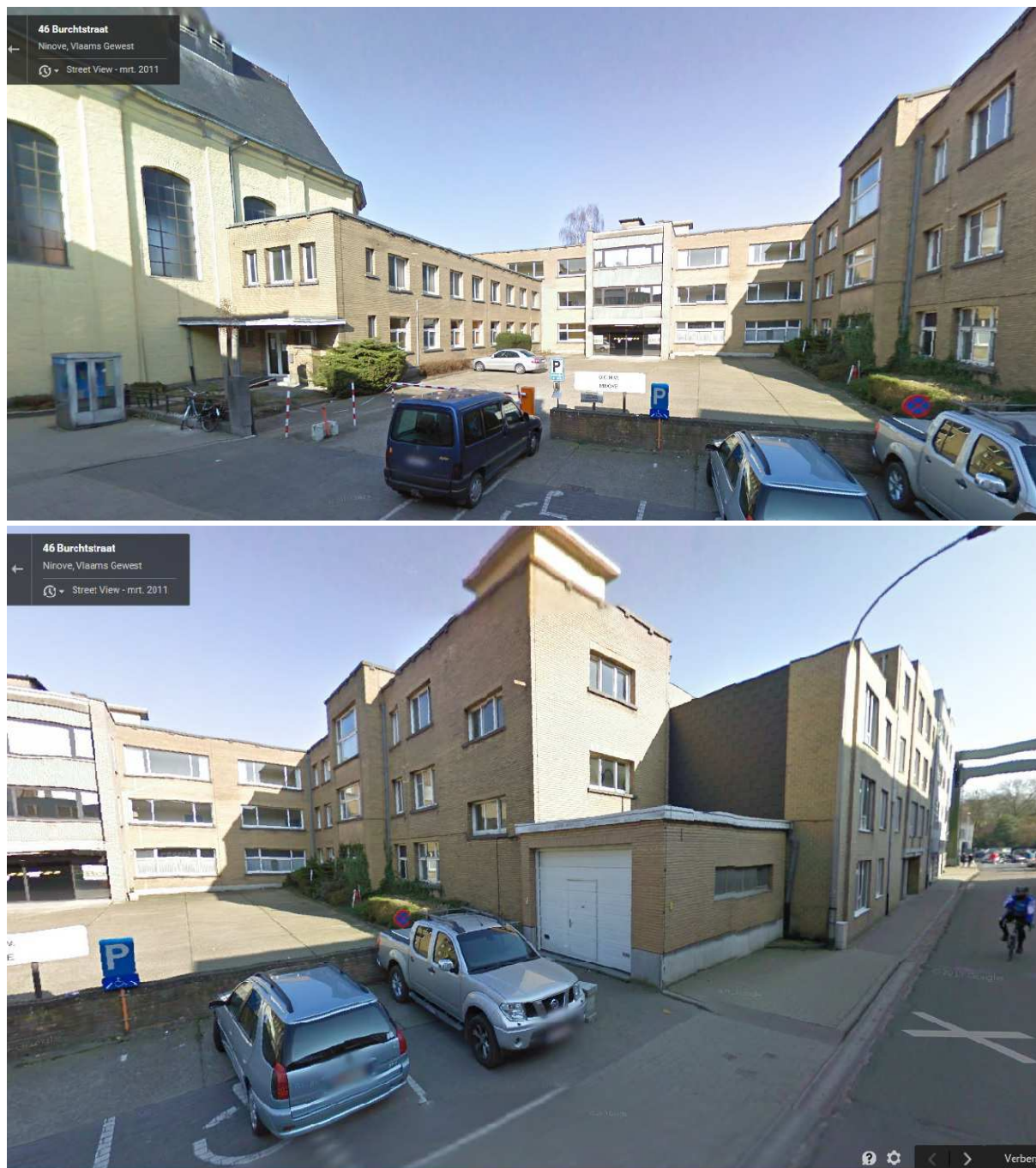
Figuur 178: beelden van het recent afgebroken OCMW hospitaal (bron: google streetview)
